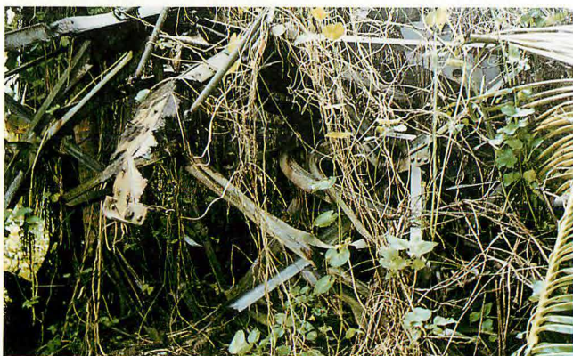
崩壊した無線塔
